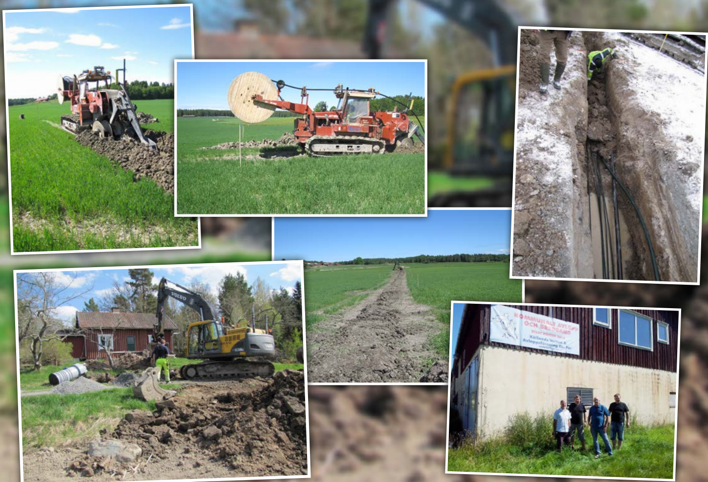
Bildsvep från Sveriges största avloppsprojekt. Entreprenören installerade även pumpstationerna på medlemmarnas tomter.
