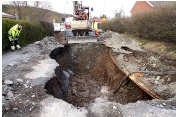
Reparation av vattenläcka pågår. Bildkälla: VA-Fakta
